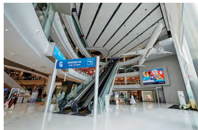
G階と3階を結ぶ高揚程エスカレーター
