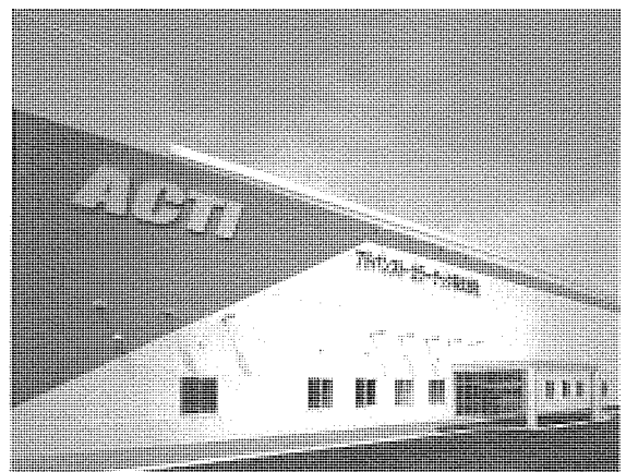
工場一括受注し完成したアドバンス・カラーテック(株)液晶用カラーフィルタ工場
