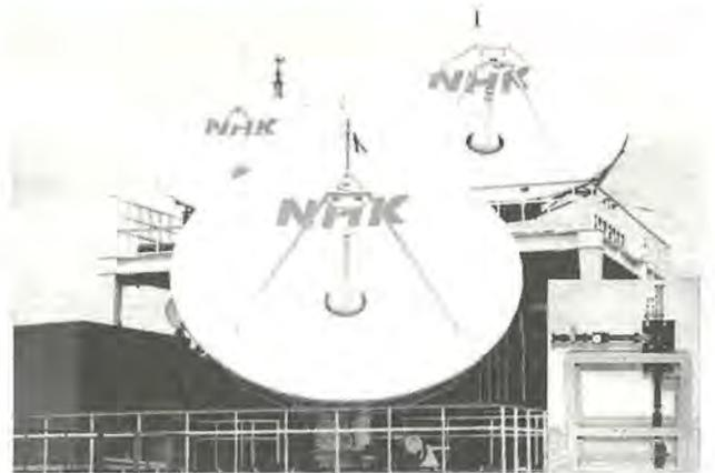
17/14/12GHz帯共用7mφアンテナと給電部
