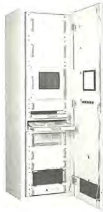
照明集中監視盤
