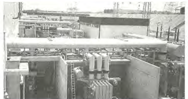
輸出处向け相分離母線 (メキシコCFE PETACALCOP/S)
