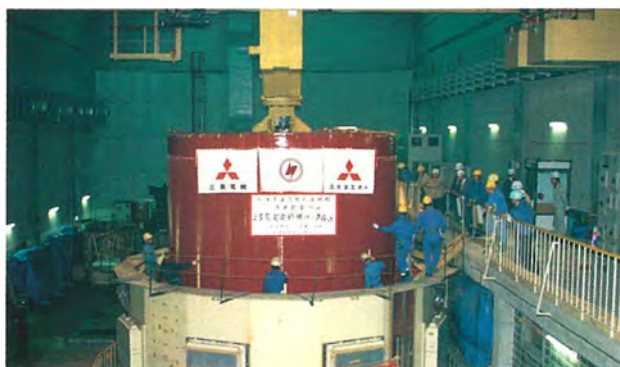
ロータ吊り込み中の可変速発電電動機
