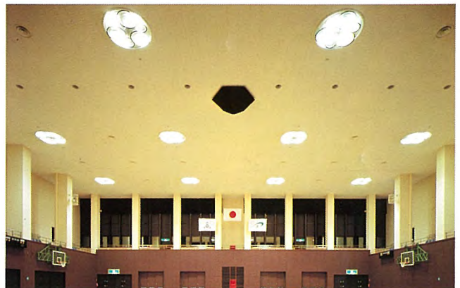
3. 福岡市立中央体育館（福岡市） 反射かさ器具4灯（メタルハイドランプ使用）を1セットにまとめ、下面に福岡市章をデザインしたルーバ付き器具を使用。明るくまぶしさを少ない省エネルギー照明。照度は平均1950lx。
