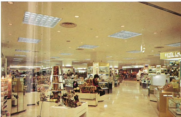
1. 東急百貨店たまプラーザ店（横浜市） 大形鏡面アルミルーバ付き蛍光灯器具を、主に電球ダウンライトを併用したシックかつ高級ムードの売場照明。光源、安定器は省電力形使用。設計照度は450lx。
