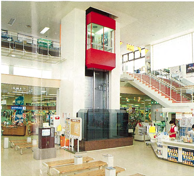
1. イトーヨーカ堂 恵庭店 店内に設けられた油圧直結式エレベーター
