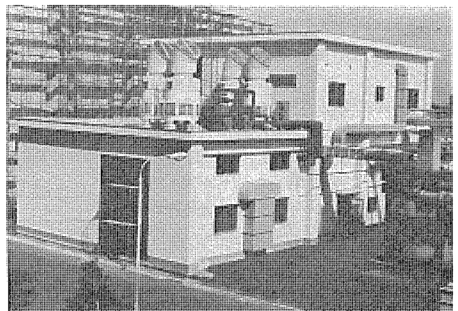
金沢市伏見川衛生処理場に建設した凍結脱水法による汚泥処理棟
