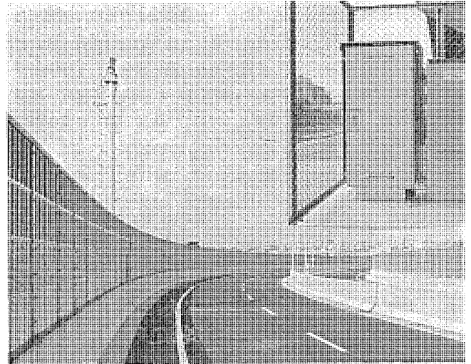
交通管制用光伝送 ITV システム
