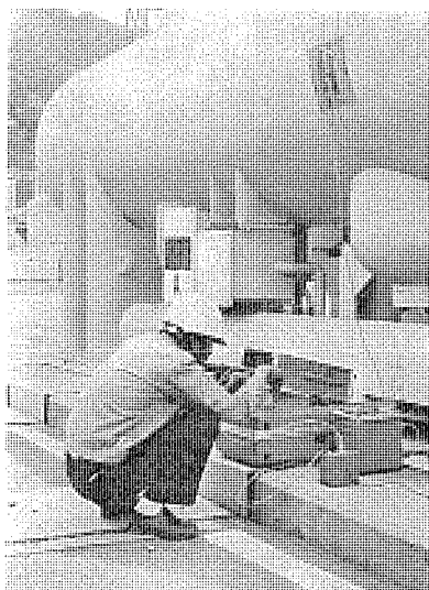
図7. 500 kV GISにおける外被電極法試験状況
