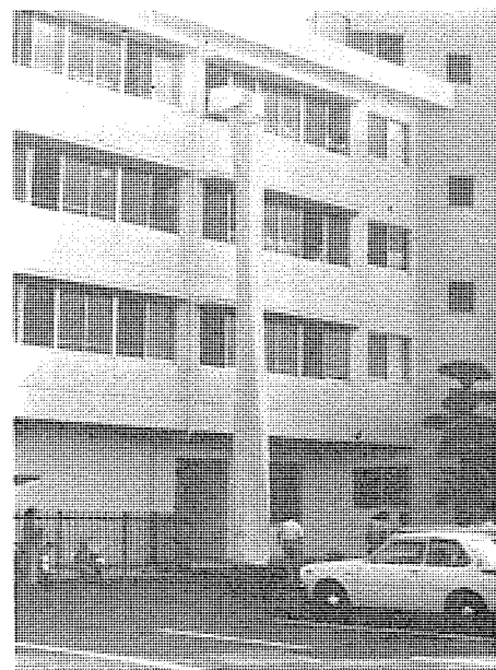
ビル避難用スパイラルシュータ
