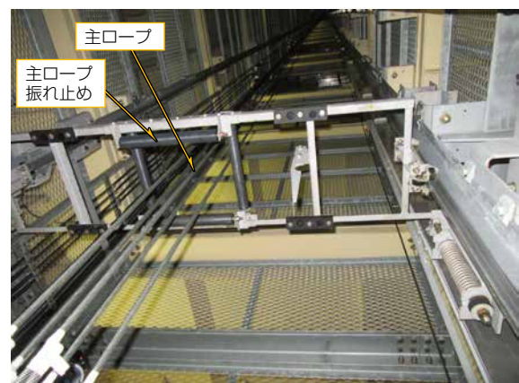
図4-昇降路固定位置に設置されている状態(昇降路見上げ)
