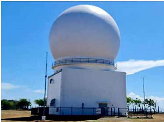
フィリピンに納入した固定式警戒管制レーダー初号機
