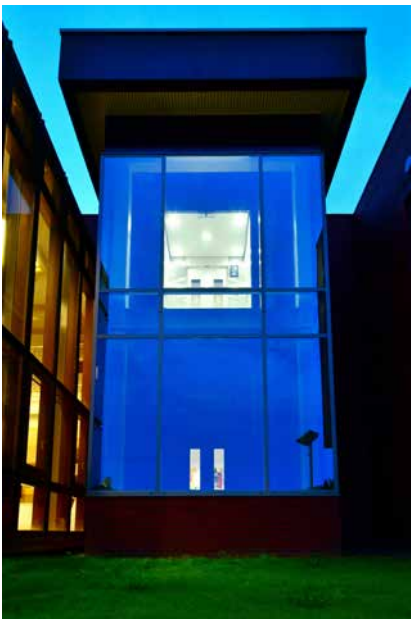
図12-白沢公民館昇降路外観
