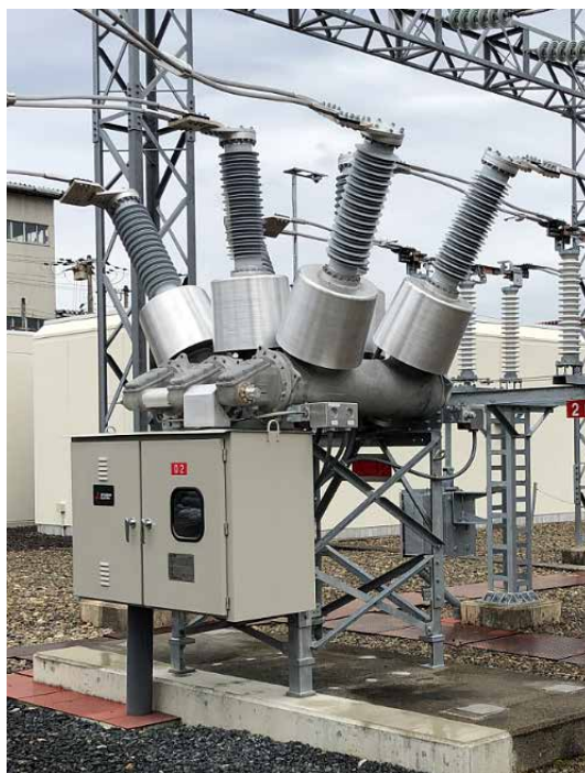
図8-72/84kV単体VCBの現地運転状況
