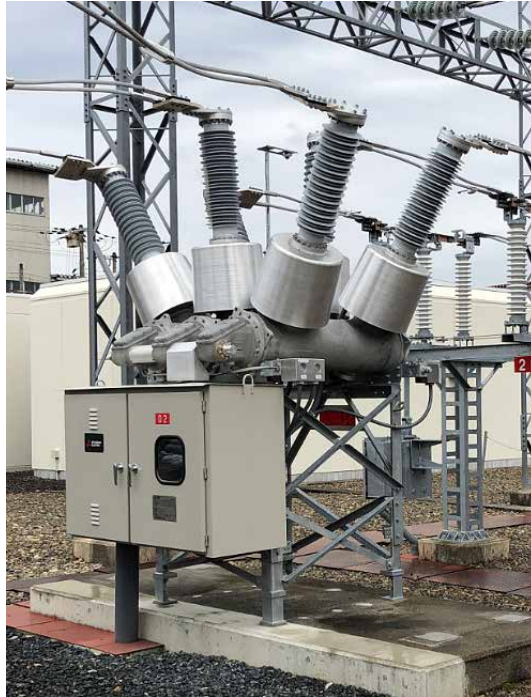
図8-72/84kV単体VCBの現地運転状況
