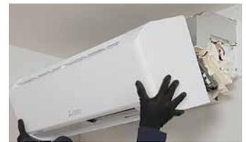
外装着脱が容易になって設置施工性が向上
