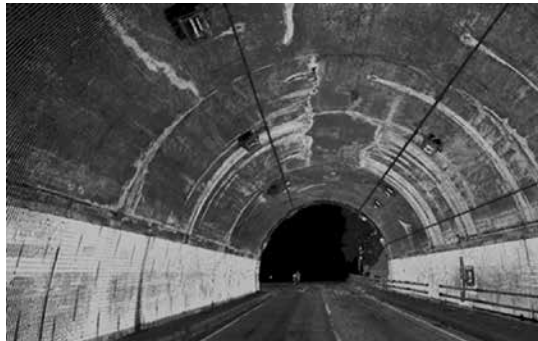
図2. 点群データ(トンネルの例)
