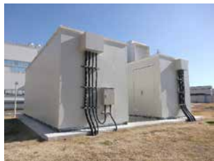
図1. 次世代機(DCマルチ電圧システム)の実証構成
