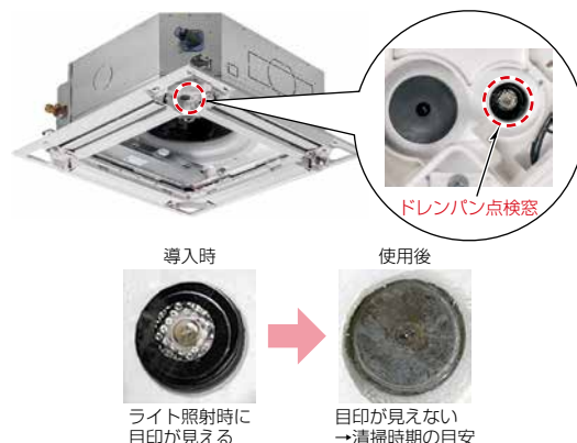
図3. ドレンパン点検窓と汚れ具合の確認イメージ
