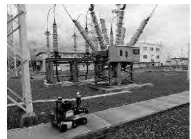
変電所での自律走行検証状況
