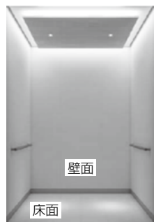
(a) 四方向とも外側に向けた間接照明中央ダウンライト照明
