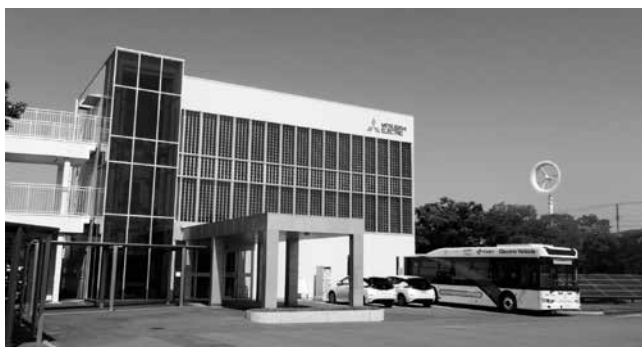
図2. 中低圧直流配電システム実証棟 (香川県丸亀市, 2016年7月稼働開始)
