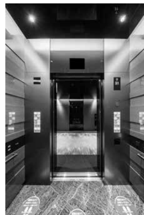
図3. かが室と操作盤
