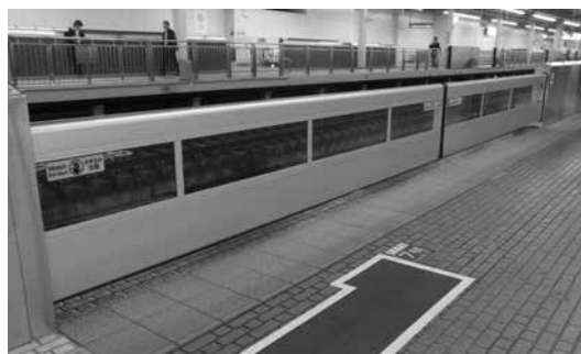
新大阪駅26番線据付の大開口ホームドア
