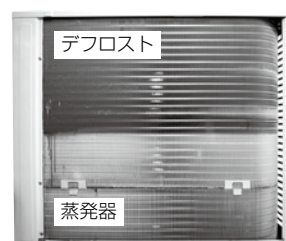
上側熱交換器デフロスト運転
