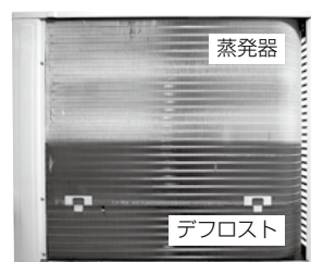
下側熱交換器デフロスト運転
