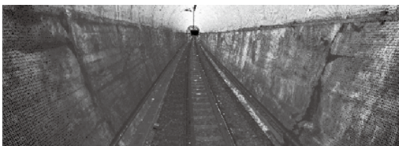
(a) トンネル部
