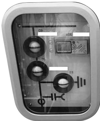
図9. ENA規格対応の表示(主回路の単線)
