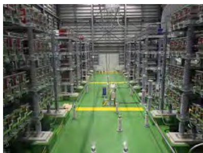
図1. 検証棟内のHVDCダイヤモンド(バルブホール)
