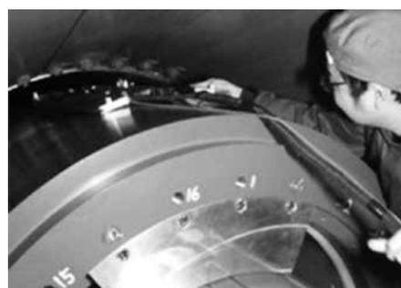
図4. 点検ロボットによるエアギャップへのアクセス
