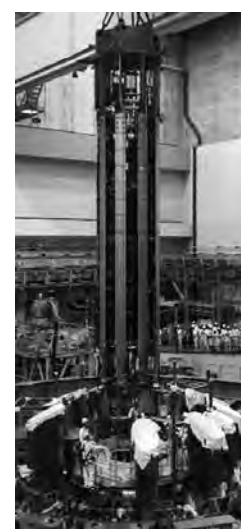
図11. CSの現地輸送・縦起こし後のトカマク本体への挿入(提供: QST)
