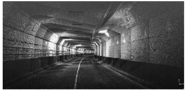
図7. トンネル走行時の点群の例
