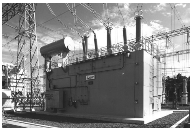
図3. 275kV変圧器へのポリマーガスブッシングの適用例
