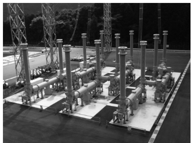
図1. 550kV GISへのポリマーガスブッシングの適用例 (1)
