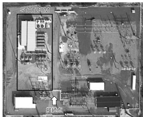
図4. 更新後Colington-STATCOMの上空写真
