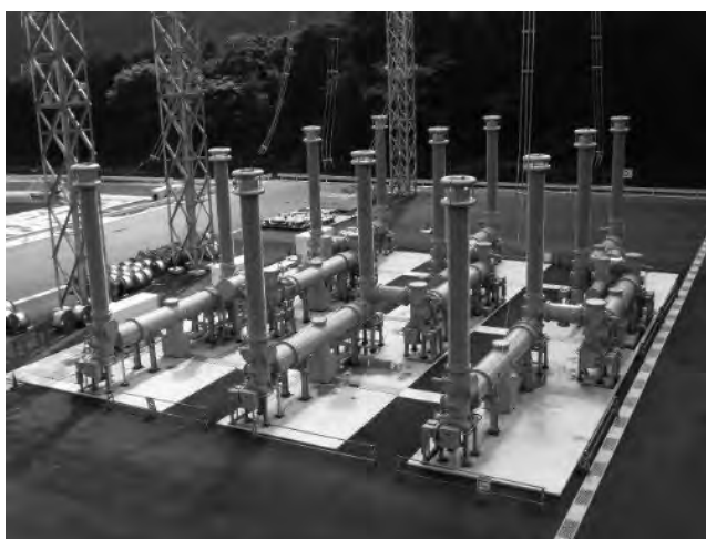
図1. 550kV GISへのポリマーガスブッシングの適用例 (1)
