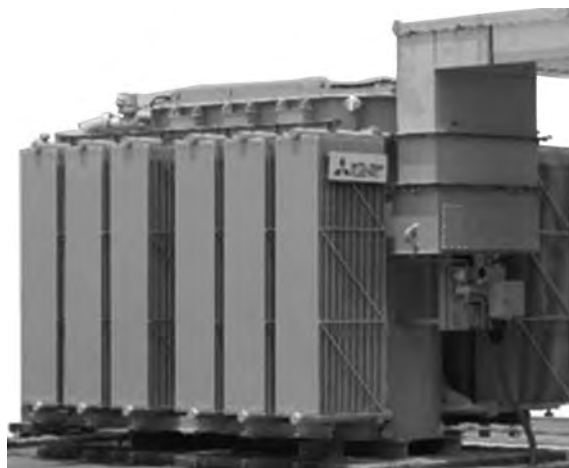
図5. 植物油入変圧器
