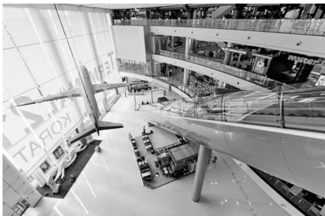
図8. エスカレーターのガラス製パネル
