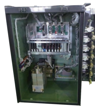
ブレーキ制御装置
