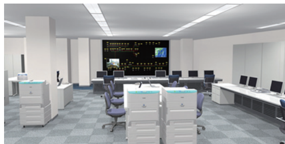
電力管理システム(指令所)
