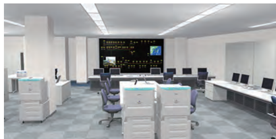
電力管理システム(指令所)
