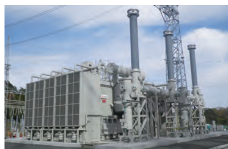
500/275kV変圧器
