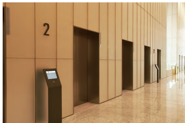
2階エレベーターホールと乗場操作盤 (奥にセキュリティゲート)
