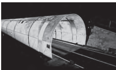
トンネルの三次元データ
