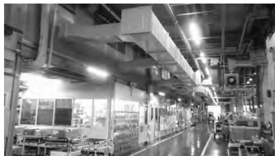
図5. R32冷媒強制排気ダクト
