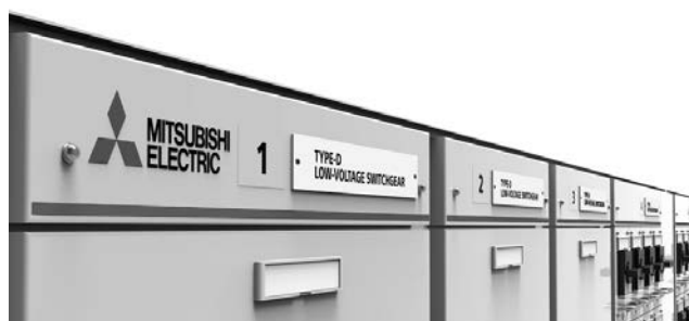
(a) MCC-Dの正面上部
