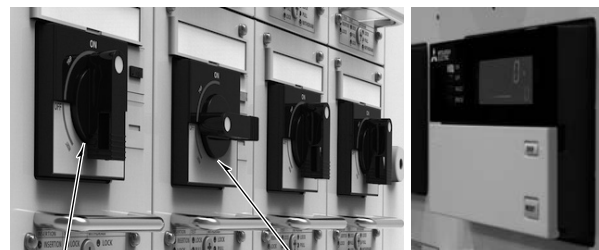
ON状態 OFF状態 MCCB : Molded Case Circuit Breaker (c) EMC-B形マルチモータコントローラ (b) MCCB操作ハンドル
