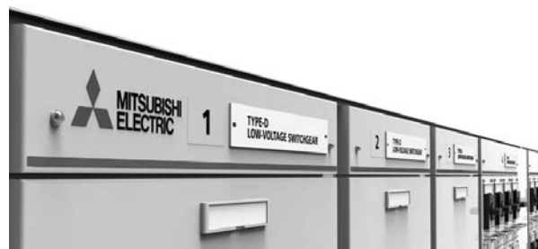
(a) D形MCCの正面上部
