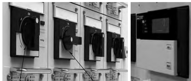
(b) MCCB操作ハンドル (c) EMC-B形マルチモータコントローラ
