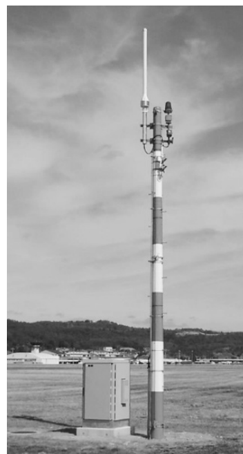
図6. 送受信装置と空中線装置の設置例
