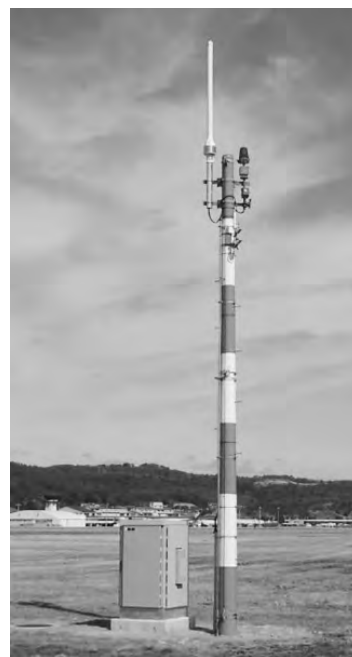
図6. 送受信装置と空中線装置の設置例
