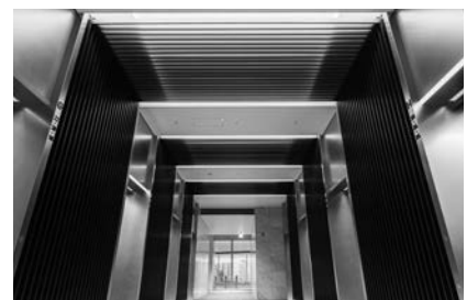
図6. オフィス用エレベーターホール
