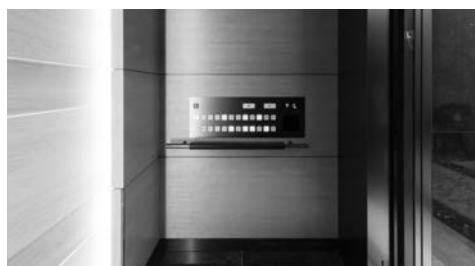
図11. 乗用エレベーターのかご内側面壁
