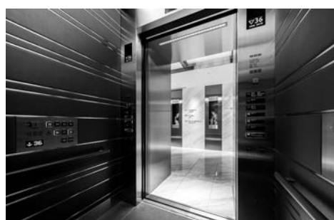
図9. 高層客用エレベーターのかご内
