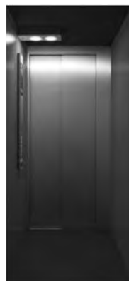
塗装仕上げ壁とLEDタイプ照明のかご室
