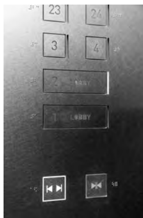
図3. 停止可能階を示す表示灯
