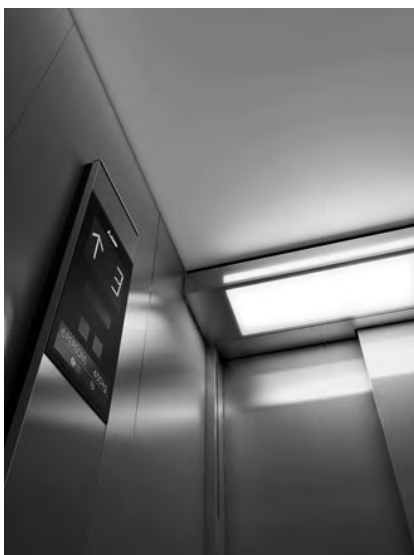
ステンレス仕上げ壁と蛍光灯タイプ照明のかご室
