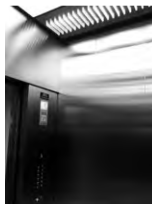
図3. かご天井の高さ拡大(天井の外法高さ3,600mm)
