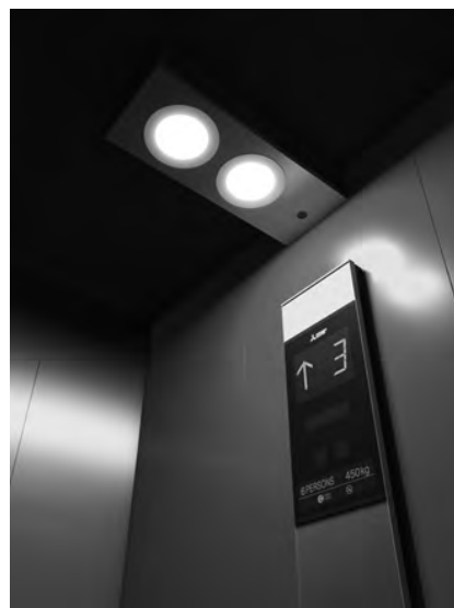
塗装仕上げ壁とLEDタイプ照明のかご室
