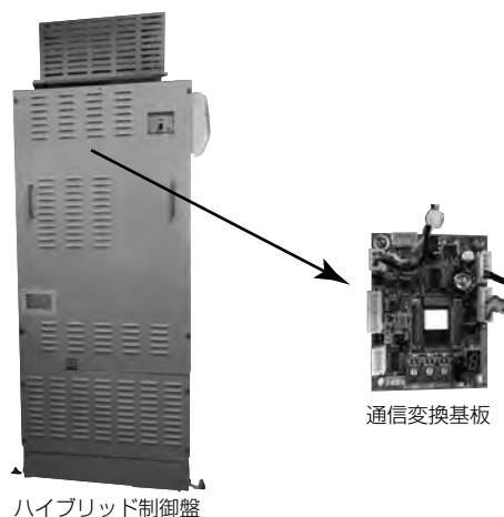
図2. ハイブリッド制御盤と通信変換基板
