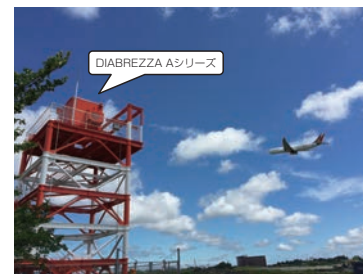
図2. 成田空港での設置状況
