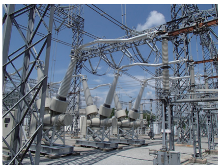
中国電力(株)新岡山変電所への新形240kV GCBの設置
