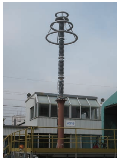
500kV系統用ポリマー形避雷器
