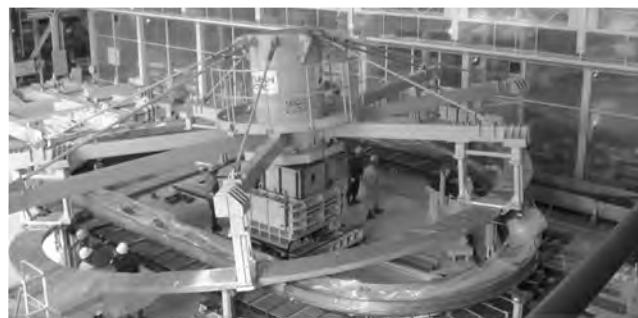
図7. トランスファ(RP挿入)作業
