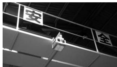
図8. クレーンへの施工例
