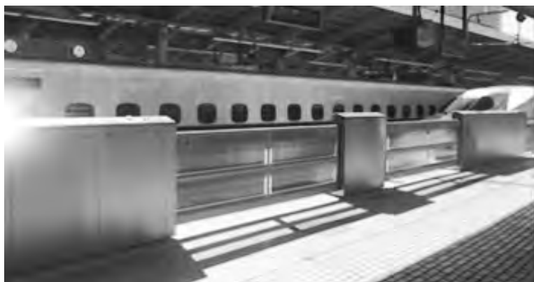
扉の長尺化(東海道新幹線向け扉長3,400mmの可動式ホーム柵)
