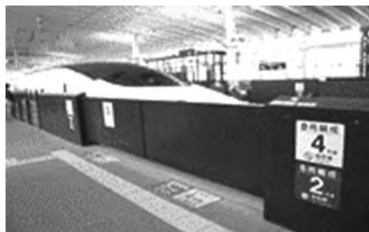
図2. 九州新幹線の長尺扉式可動式ホーム柵
