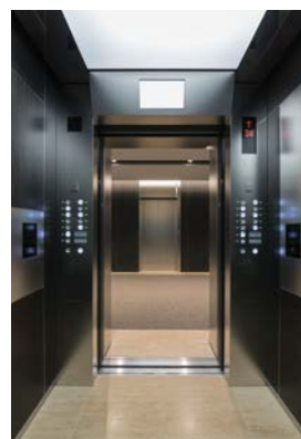
図2. ダブルデッキエレベーターのかが室内
